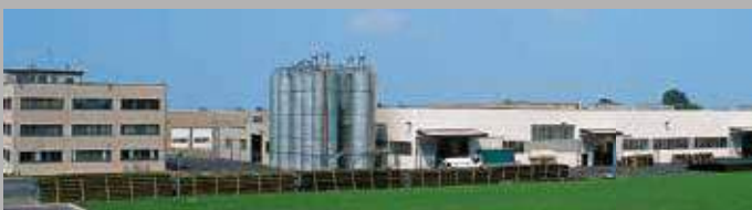
Établissement de production - Imola (BO)
